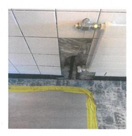
Actuellement, un vestiaire sur deux ne peut plus être chauffé normalement. Les conduites endommagées ont été bouchonnées par un installateur sanitaire.
