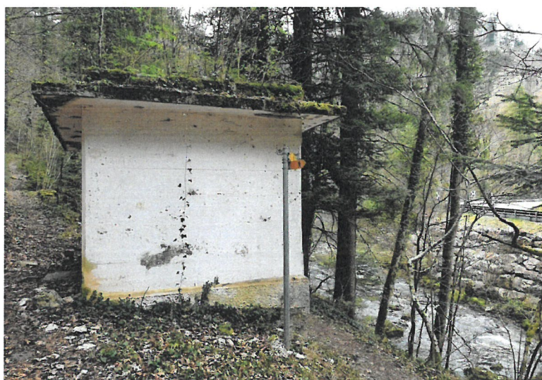
Vue du réservoir de compensation, sur la droite de l'image, on distingue le grand virage situé dans les gorges entre Berlincourt et Undervelier, avant les Forges
